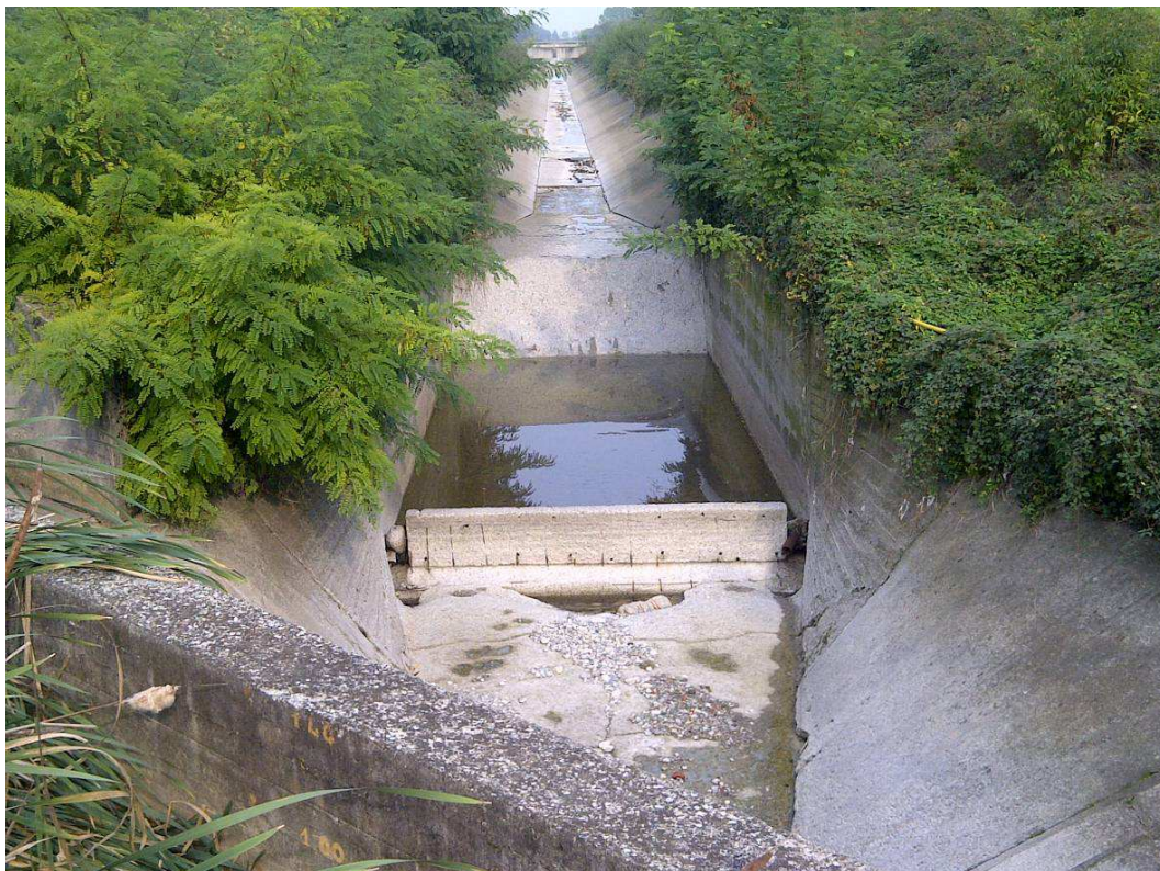
Figura 38 – Vasca di dissipazione esistente a valle del salto ove a monte è prevista la realizzazione dell'opera di presa dal CSNO
